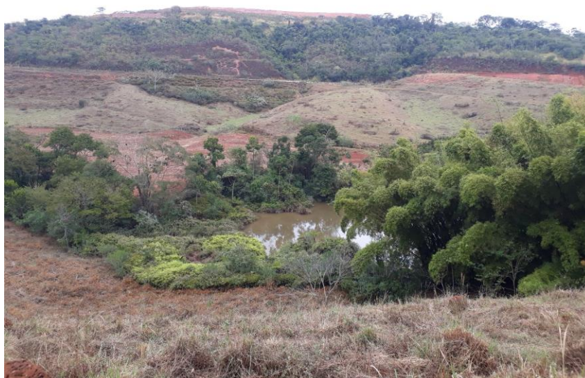
Figura 44 - Bacia de cabeceira da nascente denominada N5 com barramento, em área à jusante do aterro sanitário de Viçosa-MG. (Coordenadas UTM: X=714.933 e Y=7.707.239. Altitude: 713 m).
